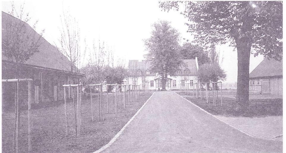
Ein Blick von der Straße macht deutlich, daß der Bauherr nicht halbherzig restaurierte und mit viel Liebe zum Detail ein Stück Poeler Geschichte bewahrte.
