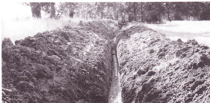
Neben den Arbeiten an der neuen Kläranlage wird gleichzeitig an der Landesstraße 121 kurz vor Niendorf eine Abwasserleitung verlegt, die das geklärte Wasser im natürlichen Gefälle von der Vorwerker Straße in die Kirchsee leiten wird.
