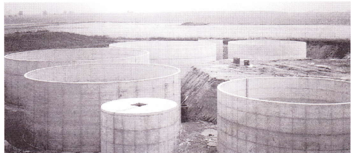
Baubeginn der künftigen Kläranlage war der 5. April 1999, und bereits nach vier Monaten bot sich dieses Bild.
