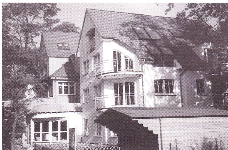
Leicht verspielt mit Erkern, Balkonen und einem vorgesehenen Laden im Erdgeschoss ist das neue Haus wahrlich ein Blickfang. Foto: Jürgen Pump
