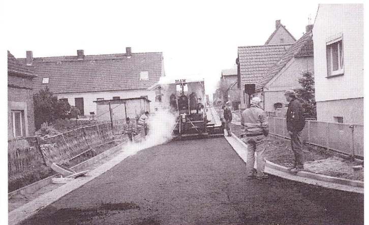
Am 10. Dezember 1999 brachten die Straßenbauer die Bitumen-Tragschicht auf.
