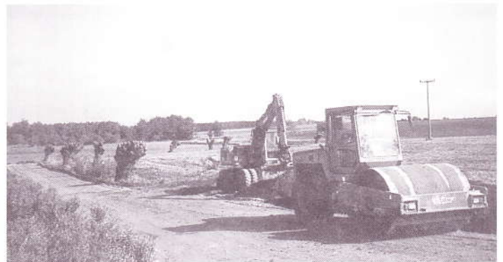
Eine Problemstelle mit viel Feuchtigkeit war bisher für die Radwanderer die Kurve kurz vor dem Anschluss an die Landesstraße 121 im Hintergrund.
