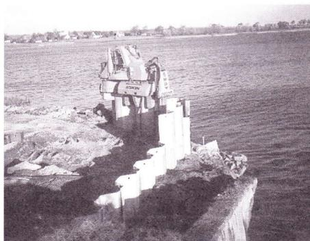
Eine Maschine, die es in sich hat. Mit 12 Tonnen Pressdruck versenkt der „SILENT PILER“ die Stahllarsen in den schweren Boden.
