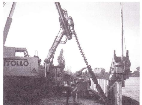
Mit so einem Schneckenbohrer unterstützte man den „SILENT PILER“, wenn der Boden Hindernisse bereit hielt.
