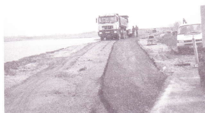
Wenige Stunden später war die erste Spur der Tragschicht verlegt.
