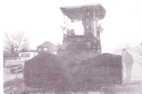
Die erste qualmende Ladung Bitumen wird verarbeitet.
