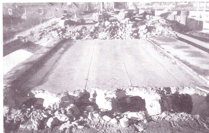
Kaum war die Überfahrt freigegeben, schon begannen die Bauarbeiter mit dem Abtragen der Straßendecke auf der alten Brücke. Hierbei kam auch wieder das alte Straßenpflaster zum Vorschein.
