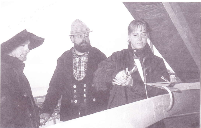
Gnadenlos verfolgten die beiden Zimmerleute, wie die Bauherrin Henoch traditionsgemäß einen Riesennagel in das Gebälk treiben musste. Das kostete schon Schweiß, aber es gelang schließlich doch.
