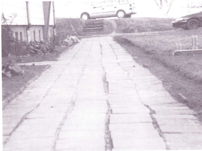
Besonders älteren Bürgern ist so ein holpriger Fußweg nicht zuzumuten.
