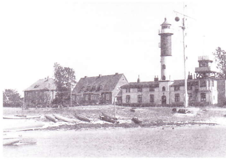
Von diesem Erkerausbau im rechten Bildteil sicherten die russischen Soldaten das Gelände. Foto: Archiv Jürgen Pump
