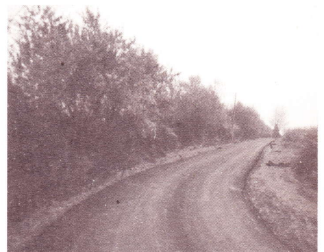
Bereits die zweite Straße entstand binnen kurzer Zeit auf der Insel Poel. Im Oktober wurde die Straße nach Brandenhusen fertiggestellt. Nun besteht auch die Möglichkeit, trockenen Fußes zur Nebelstation in Gollwitz zu kommen (unser Bild).
