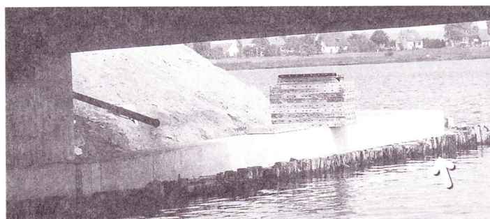
Unterhalb des neu geschütteten Betonfundamentes ist hier die alte hölzerne Spundwand zu erkennen. Sie wurde nun von den Tauchern mit einer pneumatisch betriebenen Kettensäge beseitigt und entsorgt.
