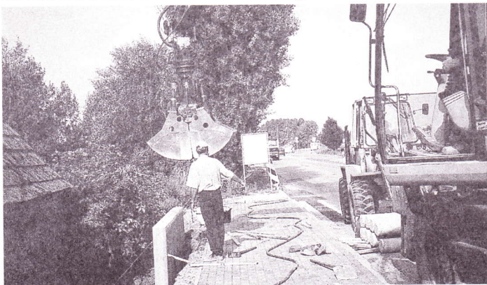
Starke Regenfälle und Sturmfluten könnten im Böschungsbereich zu Erdrutschen führen. Dies soll durch die Palisaden verhindert werden.
