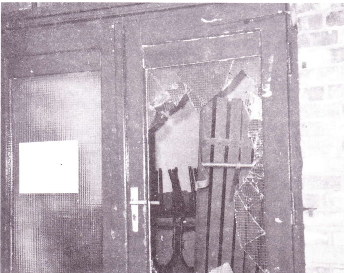
Auch die Eingangstür blieb nicht verschont. Eine Bank wuchtete man durch das Drahtglas der Tür in den Vorraum.
