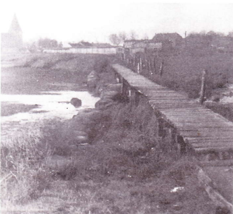
Hier eine Ansicht des verbesserten Steges. Zuvor gab es nur einen primitiven Bohlenbelag. Links des Steges sehen wir noch den alten Steinstieg.
