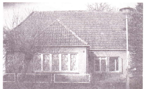
Sanierungsobjekt in der Thälmannstraße
