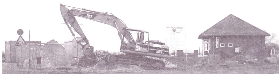
Baumaterialien und Baufahrzeuge bestimmen das derzeitige Bild am Hafen von Timmendorf. Geplant ist, dass die Baumaßnahmen bis Ende April abgeschlossen sind.
