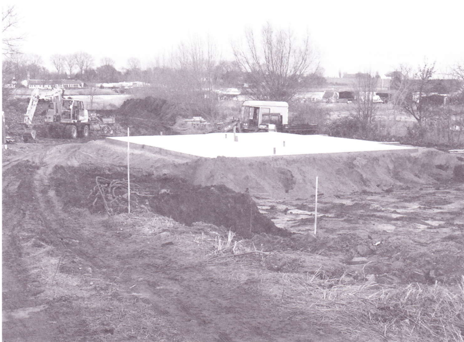
Die Firma Germania-Immobilien errichtet Am Markt 3-4 in Kirchdorf drei Mehrfamilienreihenhäuser – laut Baugenehmigung ist im vorderen Gebäude, parallel zur Landesstraße eine gastronomische Einrichtung geplant. Die Rohbauarbeiten sollen im April 2006 abgeschlossen sein. Gabriele Richter
