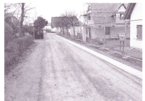
Im Zusammenhang mit der Erschließung des Baugebietes in Timmendorf-Strand (Straßenbezeichnung: Kapitänsring) durch die Firma NCC wurde die Straße nun mit einer Schwarzdecke befestigt. Für die Leistung bedankt sich die Gemeinde Insel Poel bei den Investoren, da so die Infrastruktur im Ort Timmendorf-Strand aufgewertet wurde. Es ist angedacht, diesen Straßenabschnitt mit einem neuen Namen in Anlehnung an das benachbarte reetgedeckte Wohngebiet zu versehen. Ich möchte die Bürger von Poel, vor allem die Einwohner von Timmendorf-Strand bitten, bei der Vergabe mit Vorschlägen mitzuwirken. Vorschläge sollten bis zum 15.01.2006 bei der Gemeindeverwaltung eingereicht werden. Gabriele Richter
