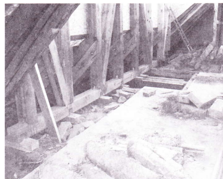
Derzeit wird der Innenausbau weitergeführt.
