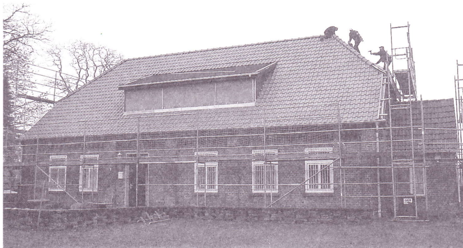
Die Dacheindeckung ist, bis auf die Gauben, fast abgeschlossen.
