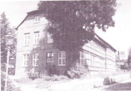
Das „Haus Mecklenburg“ in Ratzeburg
