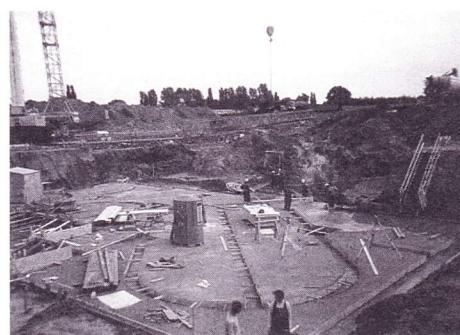
Schon kurz nach den Abrißarbeiten bot sich Ende des Monats September dieses Bild. Die Baugrube des Schwimmbeckens war bereits ausgehoben und Teile des Fundaments gegossen.
