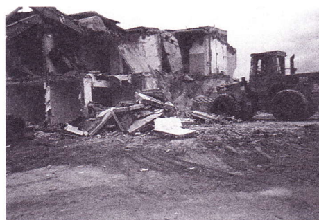
Der Abbruch aller Gebäude des ehemaligen Armeeobjektes am Schwarzen Busch ging in Windeseile. Mit schwerem Gerät schaffte man Baufreiheit für die neue Kurklinik.
