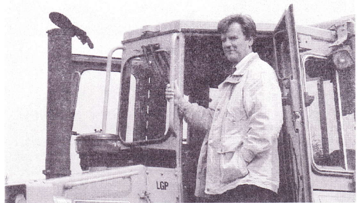
Der Poeler Bürgermeister startete mit einer Raupe das Wohnungsbauprojekt am Krabbenweg.
