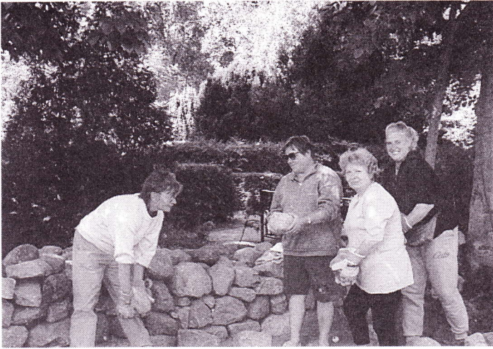
Poeler ABM-Kräfte erneuern die Friedhofsmauer in der Wismarschen Straße.
