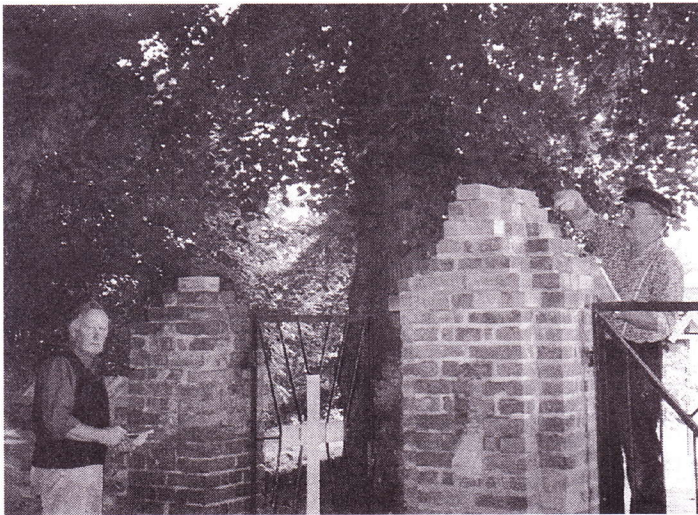
In ehrenamtlicher Tätigkeit restaurieren Heinz Rust (r) und Karl Mirow die Pfeiler des Eingangstores zum Friedhof an der Kirche.
