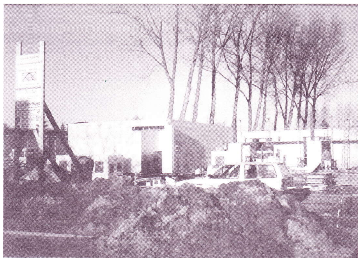
Trotz Frost und schlechten Wetters gehen die Bauarbeiten am neuen Feuerwehrgebäude zügig voran.
