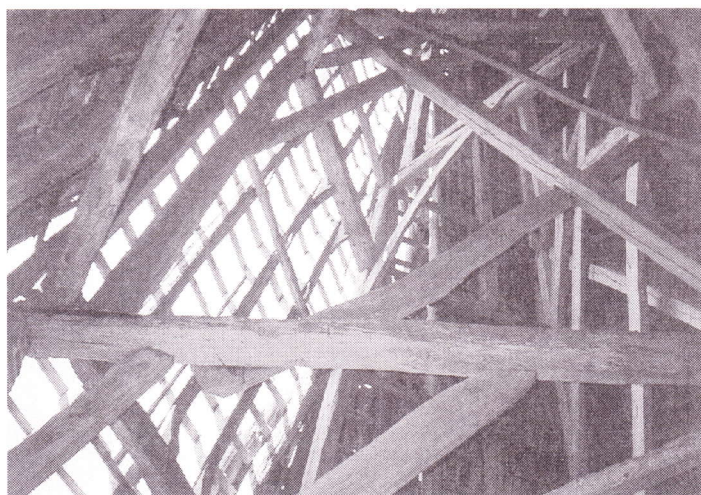
Wie dringlich die Neueindeckung des Poeler Kirchturms ist, beweist die klaffende Lücke an der Nordwestseite der Kirche.
