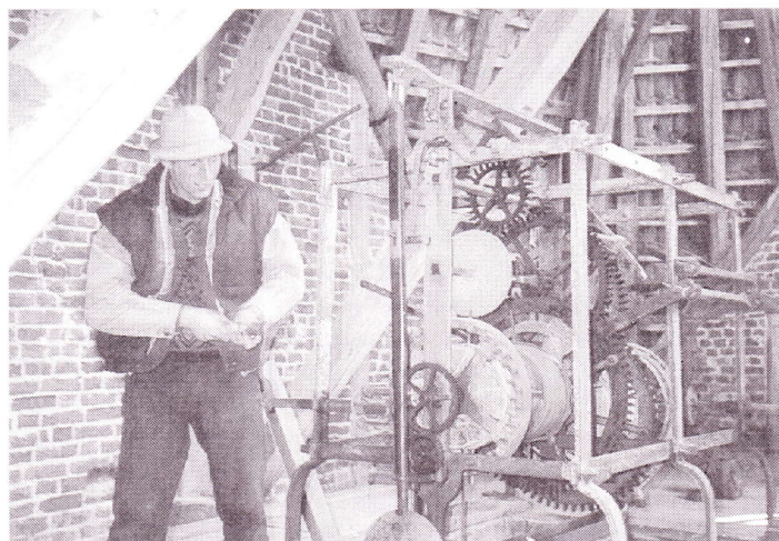
Wind und Wetter haben leichtes Spiel, so daß auch das Uhrwerk der Turmuhr gefährdet ist. Hier auf diesem Foto bemüht sich der Zivildienstleistende Marcus Reek um die Technik des Zeitmessers.
