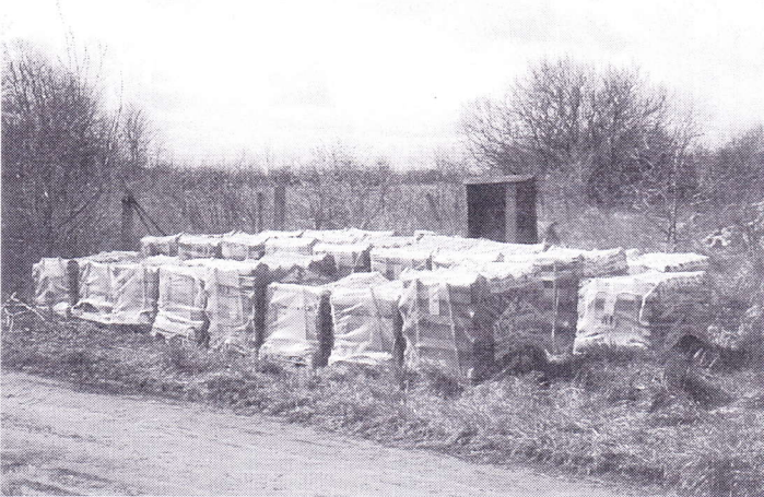
Die ersten Dachsteine für die Neudeckung des Poeler Kirchturms sind eingetroffen.
