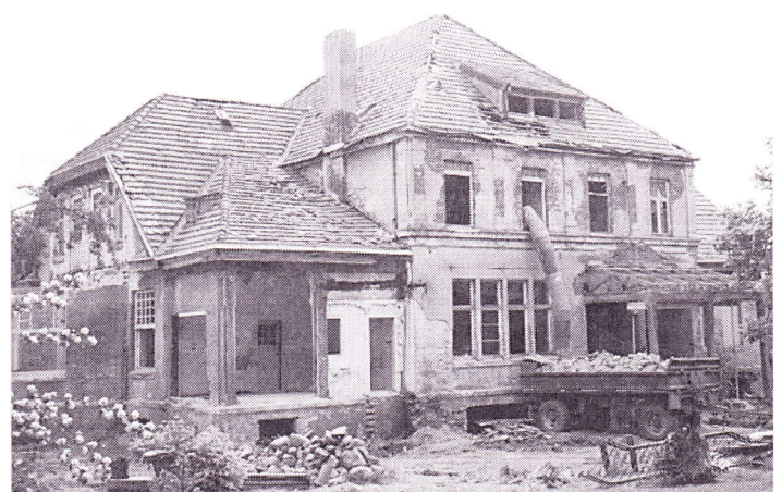
Einst ein gepflegtes Anwesen, verkam das Gutshaus und die ehemalige Pension von Friedrich Steinhagen in den letzten Jahrzehnten zur Ruine.
