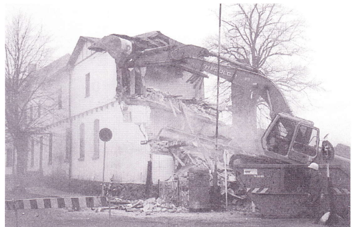
Grob ging der Bagger zu Werke und nach wenigen Minuten war bereits die erste Mauer gefallen. Wehmütig wird so manch ein Poeler die Abrißarbeiten dieses alten Anwesens verfolgt haben.
