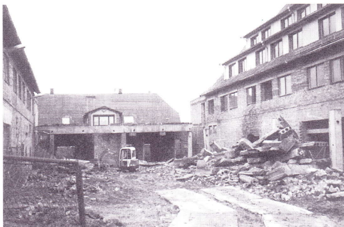
Dieser Bereich zwischen den Zwillingruinen wird nach vollständigem Abriß neu gestaltet. Geplant ist eine Gaststätte und mehrere Läden.
