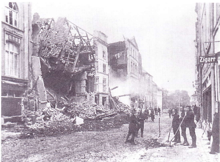
In der Altwismarstraße waren ebenfalls Schäden zu verzeichnen.
