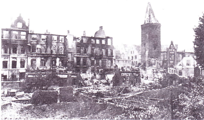
Hinter der Turmstraße bot sich ein Bild der Verwüstung.
