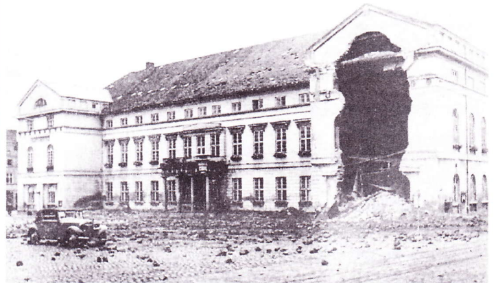
Auch das Wismarer Rathaus wurde in Mitleidenschaft gezogen.
