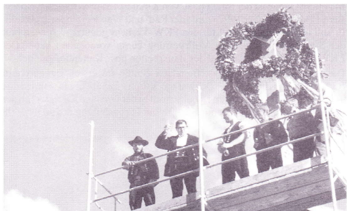
Mit einem langen Spruch und einem Umtrunk würdigte Zimmermeister Werner Rick diesen Augenblick des Richtfestes am künftigen Gemeindezentrum. Fotos: Jürgen Pump
