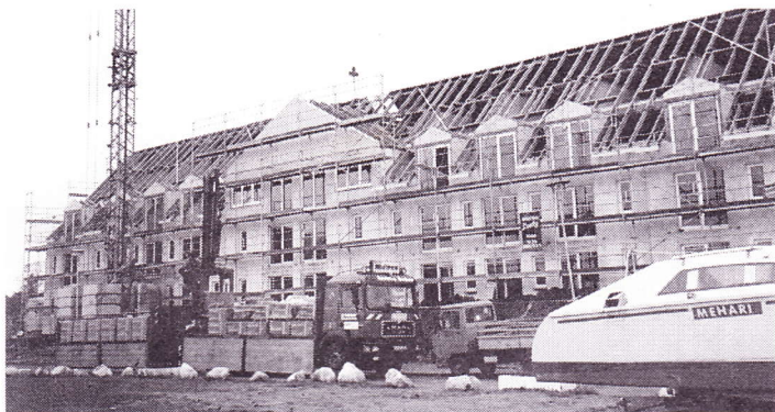
Gleich drei Gebäude entstehen zugleich am Kirchdorfer Hafen. Anstelle des ehemaligen „Völterschen Gartenrestaurants“ wird es künftig ganz anders aussehen. Hier auf diesem Foto zeigt sich die Vorderfront des Hauptgebäudes, das dem Hafen zugewandt ist.
