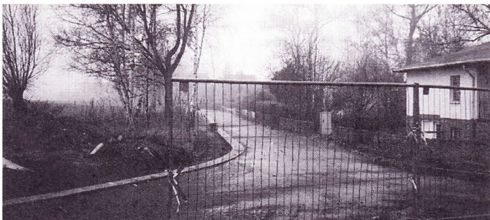
Den Abzweig hinter den Wochenendhäusern am Schwarzen Busch bituminierte man zuerst. Knapp 200 Meter sind nun gut befahrbar. Es ist beantragt, diesen Weg im Rahmen des ländlichen Wegebbaus weiterzuführen.
