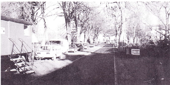
Die Tragschicht der neuen Straße entlang des alten Friedhofs ist bereits fertiggestellt. Deutlich ist am linken Bildrand der Streifen zu erkennen, auf dem Grünstreifen, Fußweg und Parkflächen entstehen sollen.
