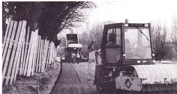
Bitumenfahrzeuge und Walzen waren Mitte des Monats Dezember 1997 dabei, den Straßenbelag zum Schwarzen Busch aufzubringen.
