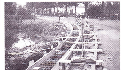
Ein befestigter Überbau aus Stahlbeton machte sich am Oertzenhofer Teich für den Fußweg erforderlich.
