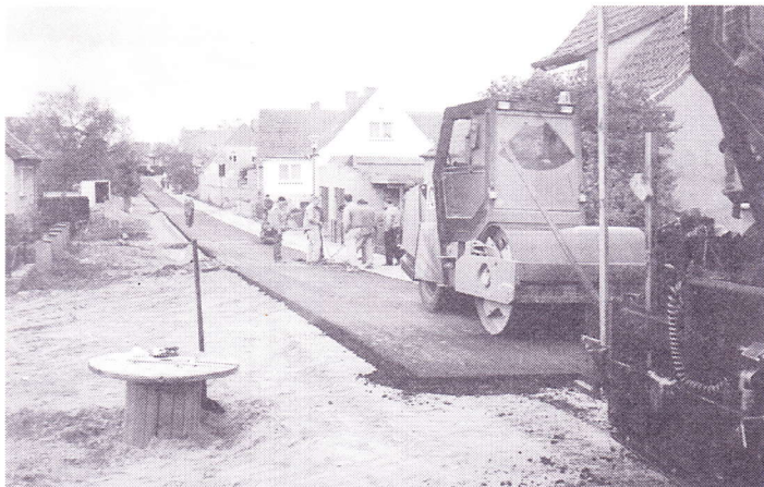
Nach den umfangreichen Tiefbauarbeiten schloß sich der Straßenbau an. Mit einer Walze wurde die Bitumen-Deckschicht unmittelbar nach der Verlegemaschine verdichtet und geglättet.
