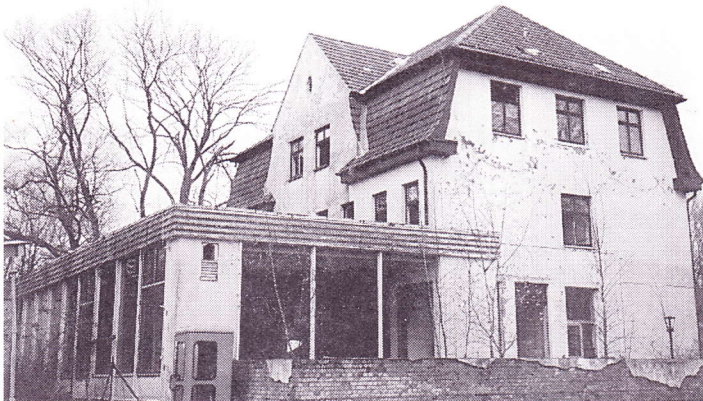
In einem erbärmlichen Zustand befindet sich das ehemalige FDGB-Heim am Schwarzen Busch. Manch ein Gast der Insel stand kopfschüttelnd vor dem einst so stolzen Kurhaus, das wahrlich bessere Zeiten kannte. Foto: Jürgen Pump
